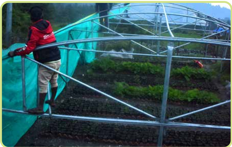
नर्सरी मर्मत कार्य अन्तर्गत टिन नेट जाली जडान
