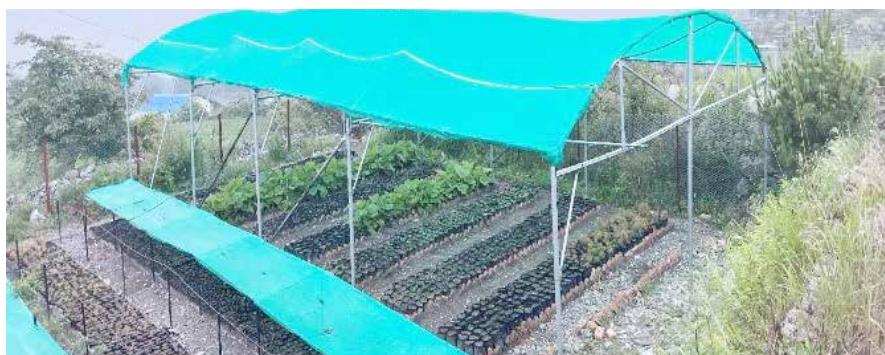
नर्सरीमा फाईवर सिट जडान र नर्सरी बेडमा सेड नेट फिटिंग कार्य
